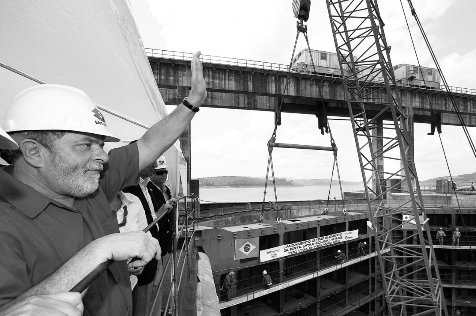
Präsident Lula besichtigt die Fertigstellung des Torbereiches eines Staudammes
