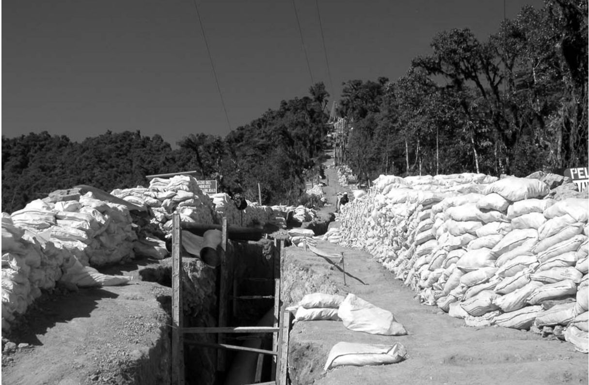
OCP-Pipeline im Bau: Bei Mindo-Nambillo durchschneidet sie ein geschütztes Vogelreservat
